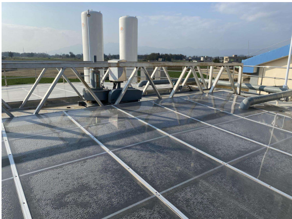
污泥浓缩间、污泥脱水车间全封闭+废气收集
