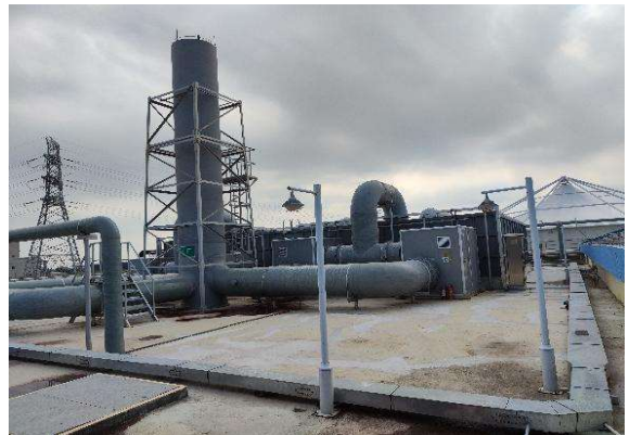
调节池、应急池全封闭+废气收集储存设施及排气筒
