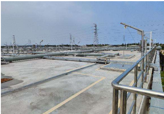
A池全封闭+废气收集初沉池全封闭+废气收集
