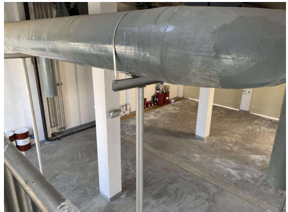
污泥浓缩间、污泥脱水车间全封闭+废气收集
