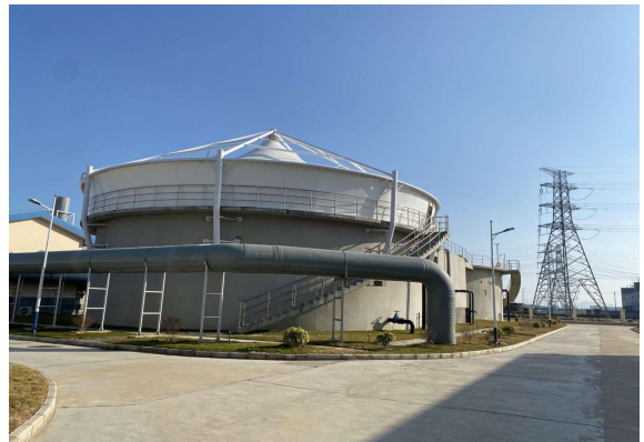
A池全封闭+废气收集初沉池全封闭+废气收集
