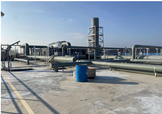
调节池、应急池全封闭+废气收集储存设施及排气筒
