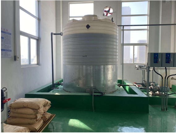
污泥脱水间药品罐围堰
