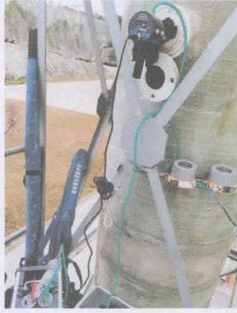
P2 甲类仓库与废水处理设施废气处理排气筒出口
